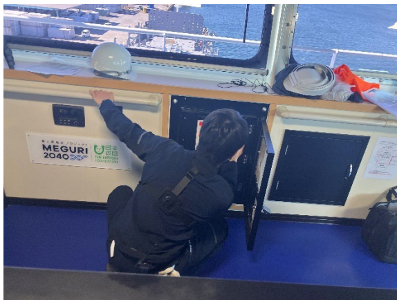
火災報知器の確認
