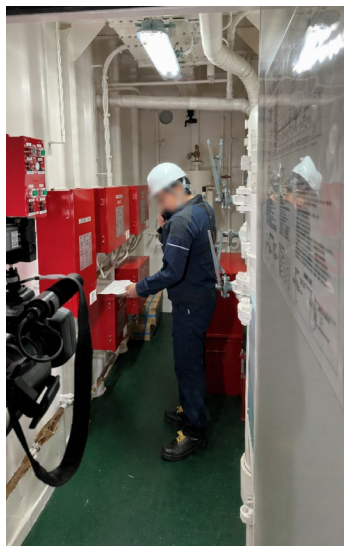
火災制御室との通信
