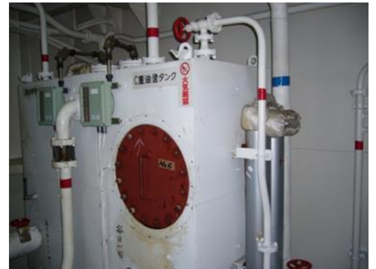
タンクの保温板。保温板をブリキ板で補強したもの
