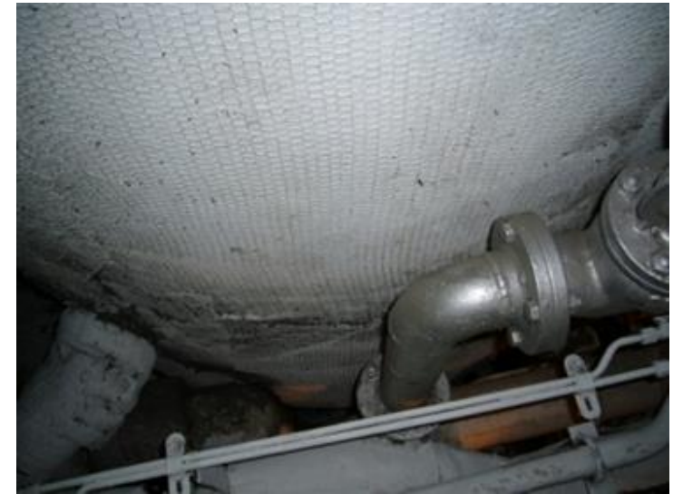
タンクの保温板。保温板の表面にアスベストクロスを貼り付けて金網で補強
