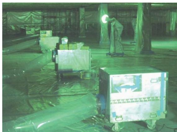
参考図 3.21 集じん・排気装置への排気ダクトの取付け
