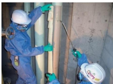
図4.7.3 保温材の取外し
