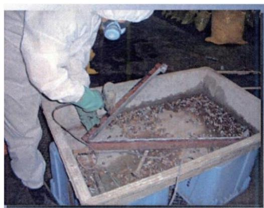
図4.10.7 掻き落とし除去作業の例
