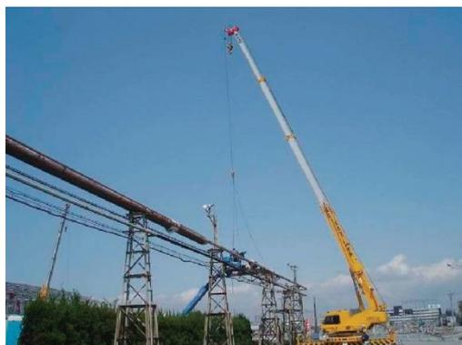
図4.8.6 配管吊り下ろし
