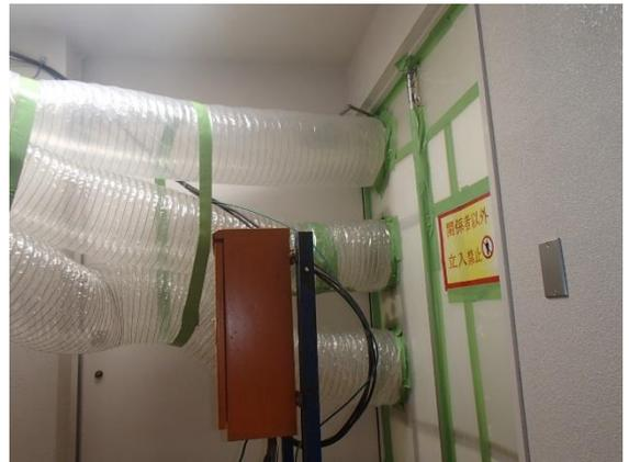
参考図3.23 排気ダクトと隔離の取合い（隙間を完全に封鎖）
