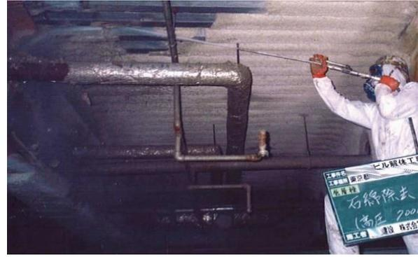
参考図 3.35 ウォータジェット工法の例
