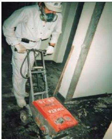
**図 4.10.3 石綿含有ビニルタイルの除去例**
