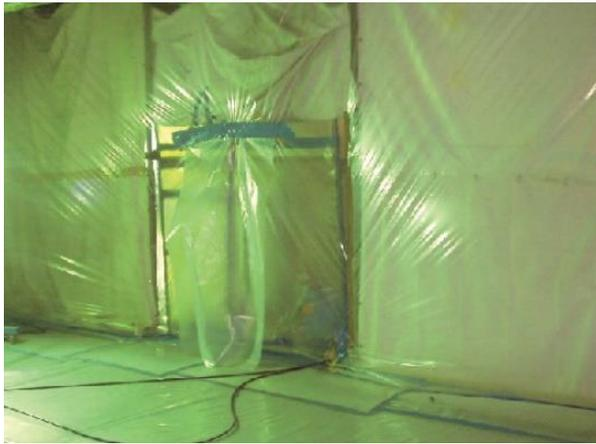
**参考図 3.6 壁面の隔離例**
