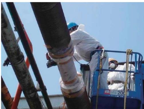
図4.8.5 切断箇所の除去と養生
