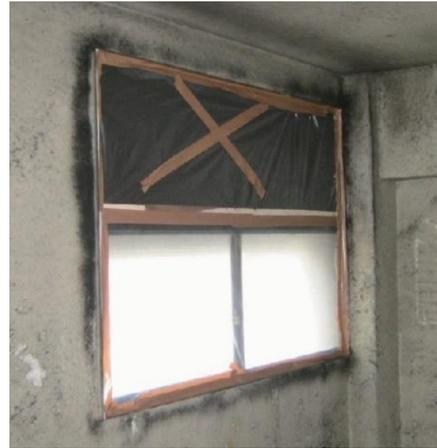
**参考図 3.7 窓、換気口の隔離例**
