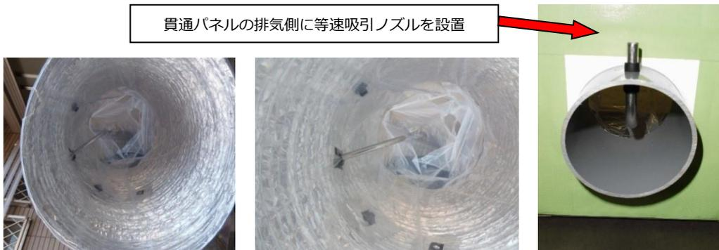
貫通パネルの排気側に等速吸引ノズルを設置
