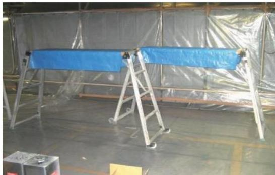
参考図3.33 可搬式作業台の例
