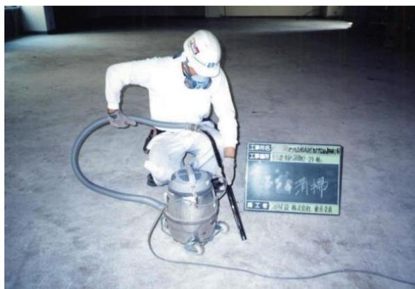
図4.10.11 清掃 高性能真空掃除機使用例
