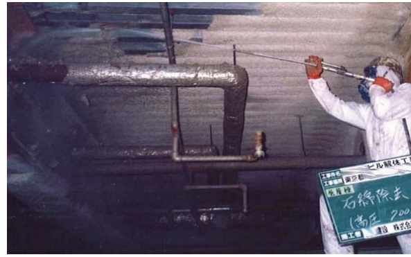
参考図 3.35 ウォータジェット工法の例
