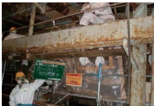
図4.8.9 特殊グローブバッグ取付作業中
