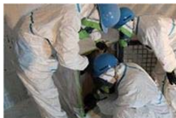
参考図 3.56 HEPA フィルタの留め付の緩み点検
