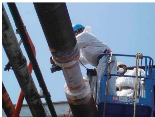
図4.8.5 切断箇所の除去と養生
