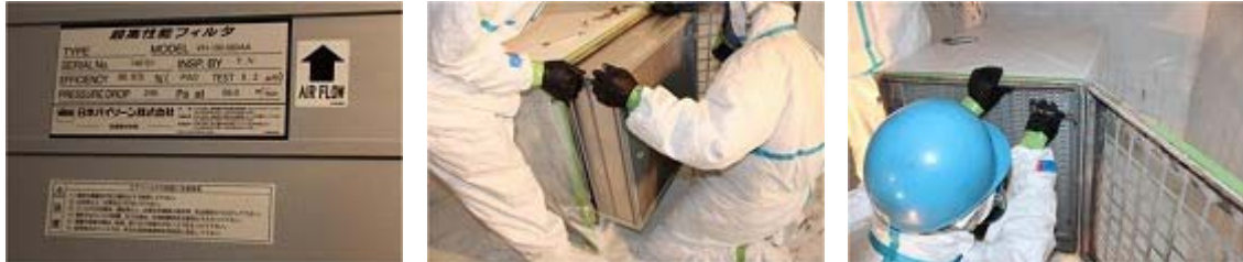
参考図 3.58 フィルタの取り付け
