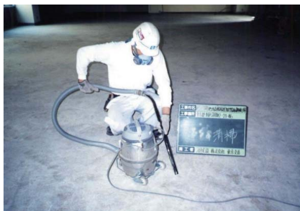
図4.10.11 清掃 高性能真空掃除機使用例
