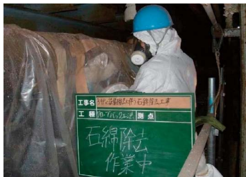
図4.8.10 石綿除去作業中1
