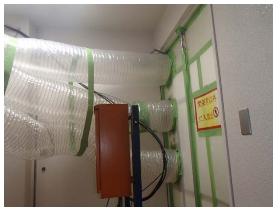
参考図3.23 排気ダクトと隔離の取合い （隙間を完全に封鎖）
