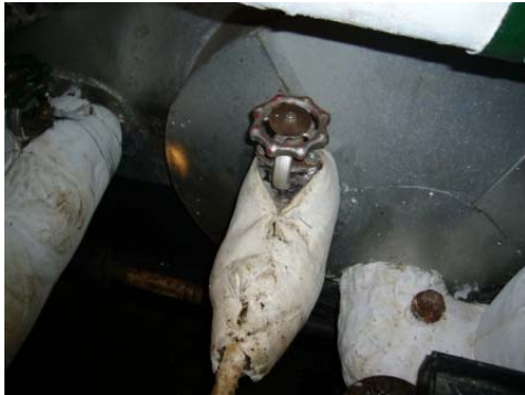
図 2-7 蒸気弁に使用のアスベスト布団（左）及び 排気管エキスパンション部アスベスト布団（右）
