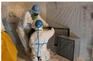
参考図 3.57 HEPA フィルタの交換
