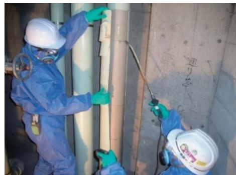
図4.7.3 保温材の取外し
