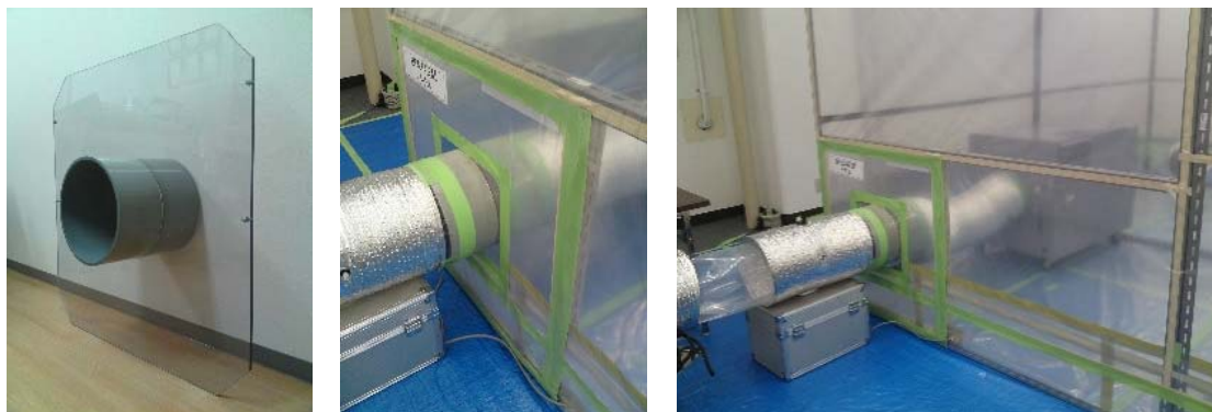
参考図 4.14 排気ダクト貫通パネル例
