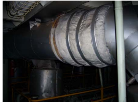
図 2-7 蒸気弁に使用のアスベスト布団（左）及び 排気管エキスパンション部アスベスト布団（右）
