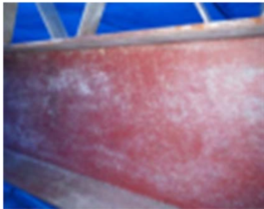
参考図3.42 再付着した石綿の例
