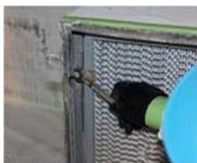
参考図 3.56 HEPA フィルタの留め付の緩み点検
