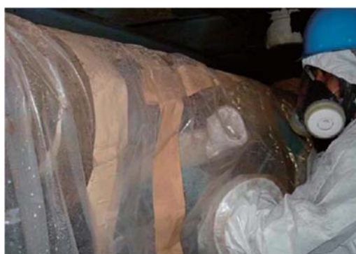
図4.8.11 石綿除去作業中2
