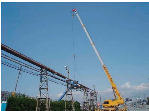
図4.8.6 配管吊り下ろし
