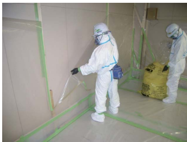
参考図3.63 隔離シートの撤去
