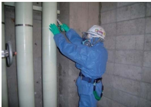
図4.7.2 保温材被覆撤去
