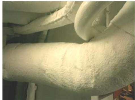
図 2-5 アスベストクロス（左）及び アスベストクロスを巻き付けた蒸気配管（右）
