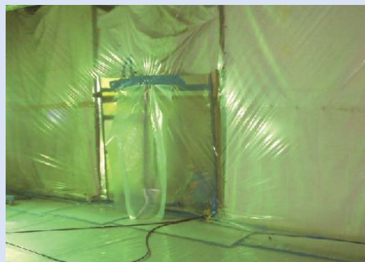
ビニールシート養生
