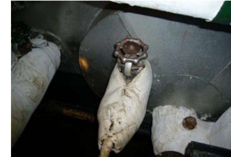
蒸気弁に使用のアスベスト布団
