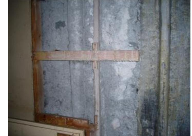
居住区壁裏の吹付けアスベスト材
