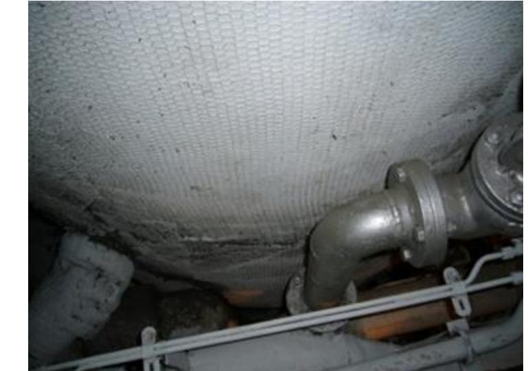
タンクの保温板。保温板の表面にアスベストクロスを貼り付けて金網で補強
