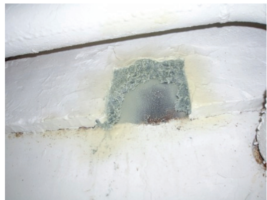
図 2-3 吹付け表面がプラスター（漆喰のようなもの）で押さえられた写真（左）。それを切り取った写真（右）
