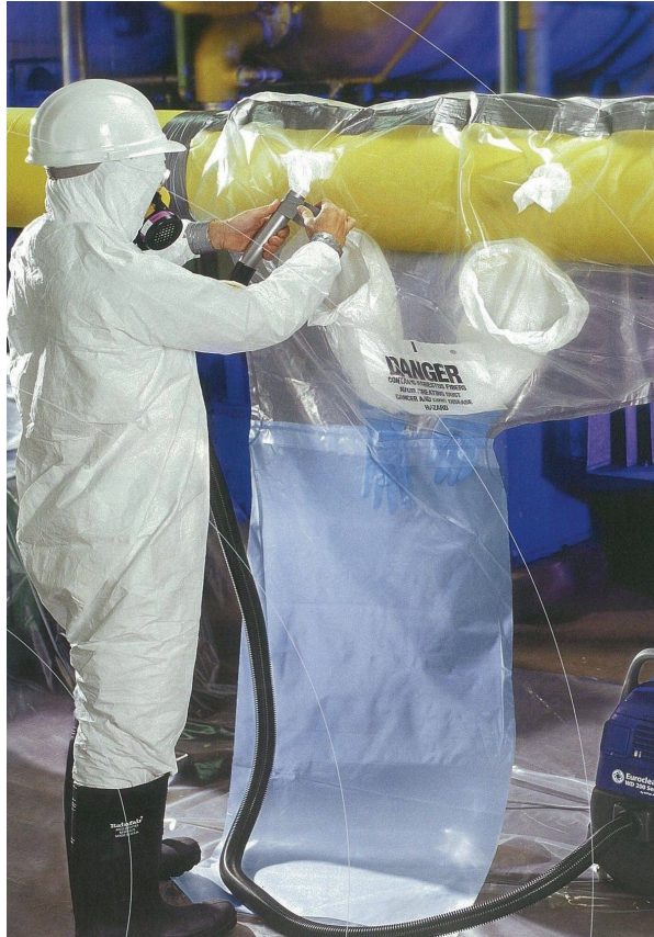
図 5-2-13 グローブバッグ工法による作業範囲が部分的な工事
