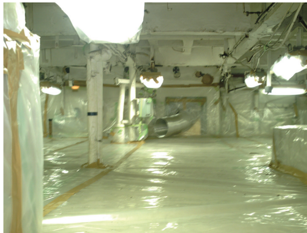
図 5-1-2 工事区画をプラスチックシート等で密閉隔離（床面は 2 枚重ね）。 ダクトで負圧・除じん装置と接続
