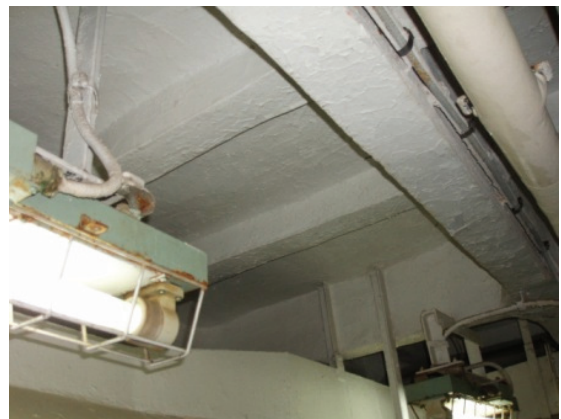
図 2-2 居住区壁裏の吹付けアスベスト材（左）及び 天井に吹付けられた結露防止アスベスト材（右）
