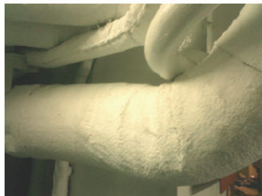
図 2-5 アスベスト糸を布状にしたクロス（左）及び アスベストクロスを巻き付けた蒸気配管（右）
