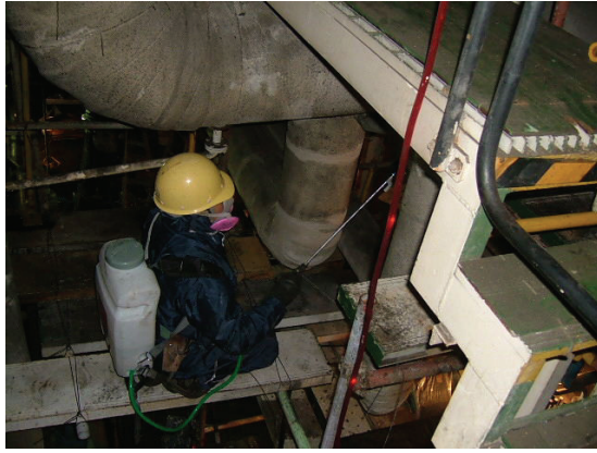
図 5-1-13 噴霧器を使用してのアスベストの湿潤作業中
