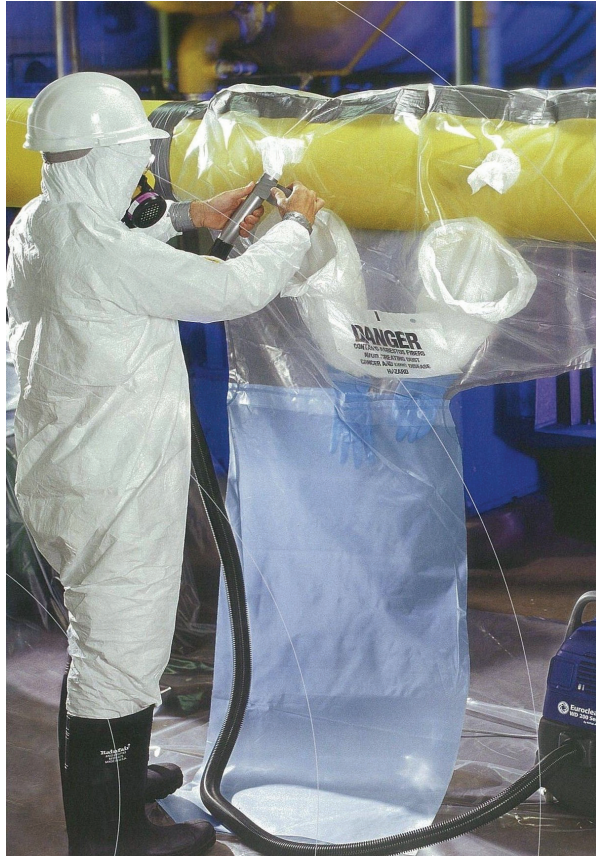
図 5-1-14 グローブバッグ工法による作業範囲が部分的な工事
