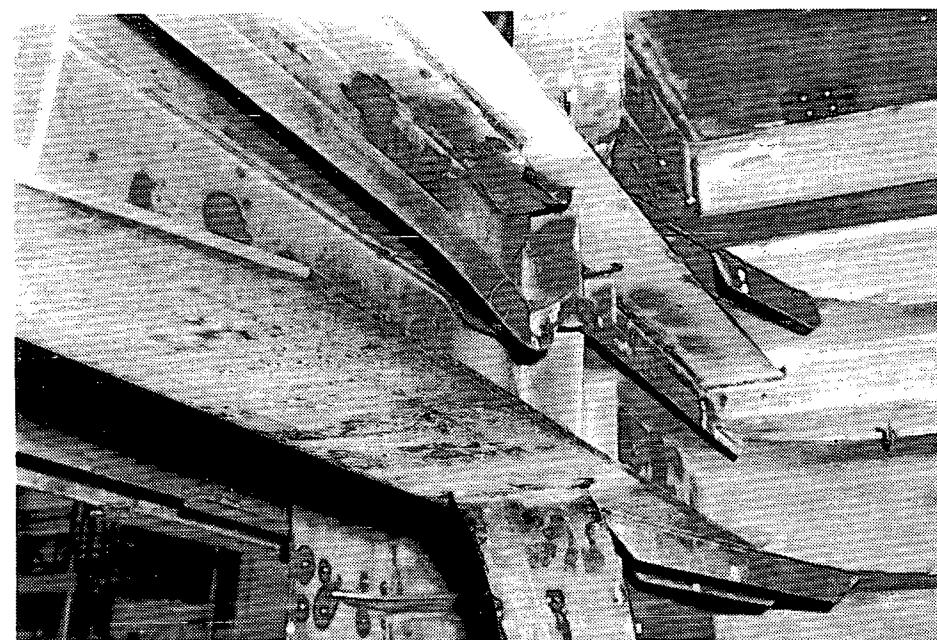
図 2.2.5 座屈部の補強状況
