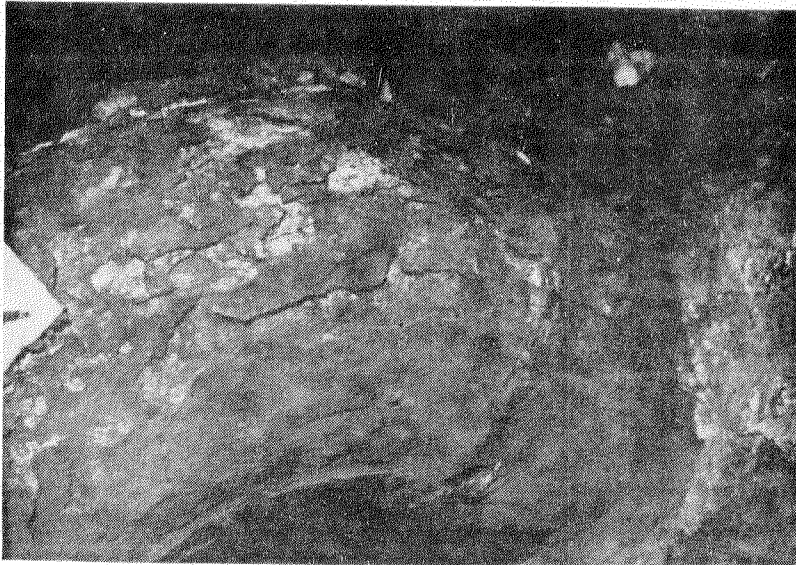
B丸 甲板テンションウインチ蒸気管
