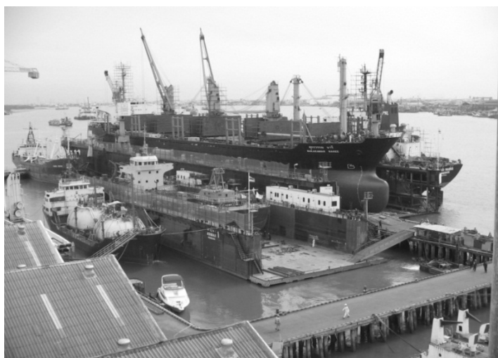
図 22 No.1 フローティングドック
