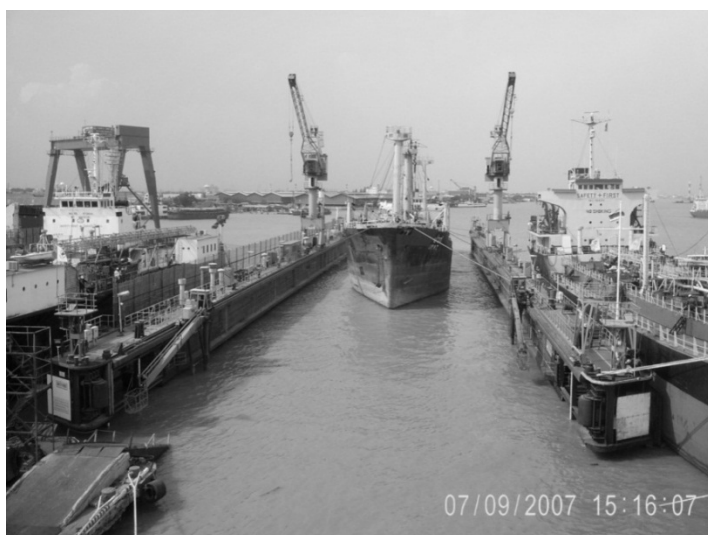
図 23 No.2 フローティングドック
