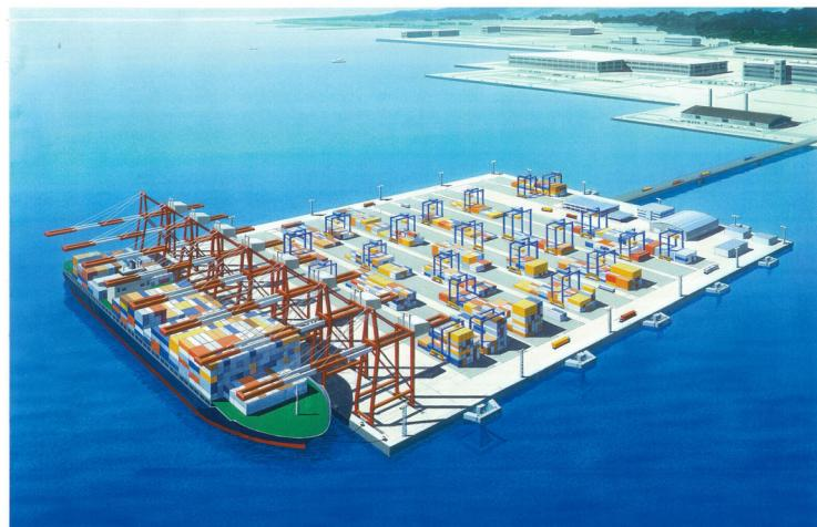
図 11 高効率浮体式コンテナターミナル
