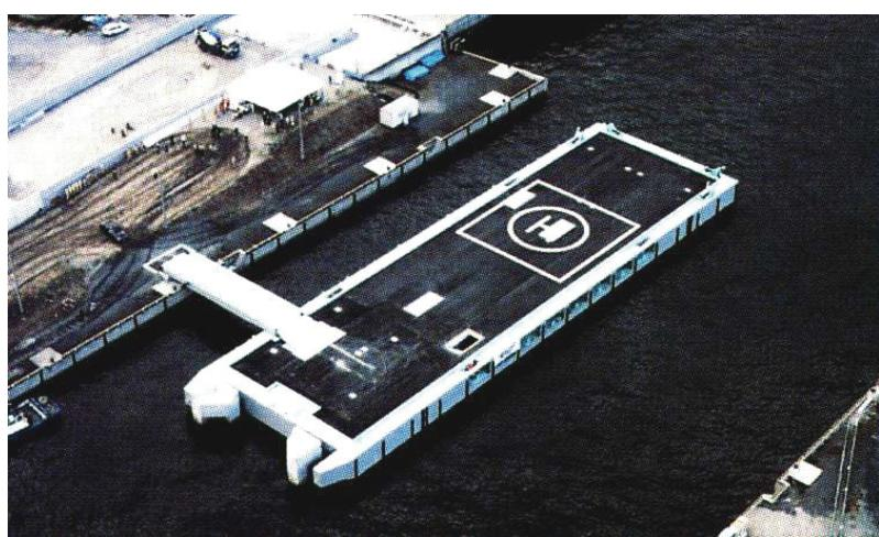
図 38 東京湾（横浜）に設置された浮体式防災基地
