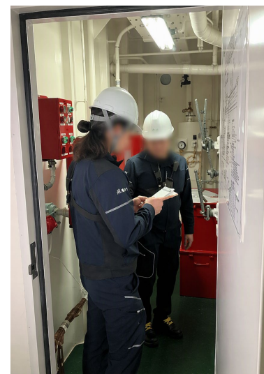
CO2 startup preparation
