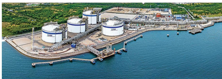
図 27 SLNG 社所有の LNG ターミナル全景と位置
