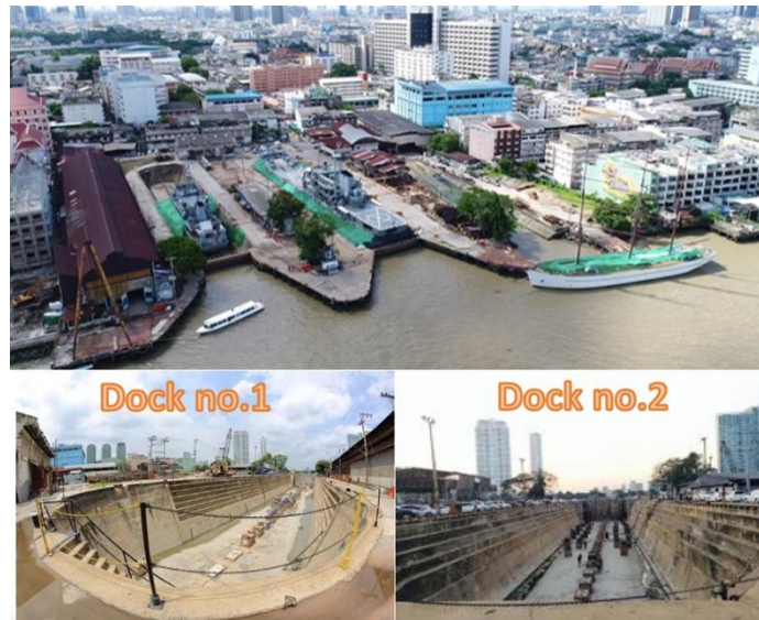
図 47 チャオプラヤー川沿いサトーン地区の造船所
