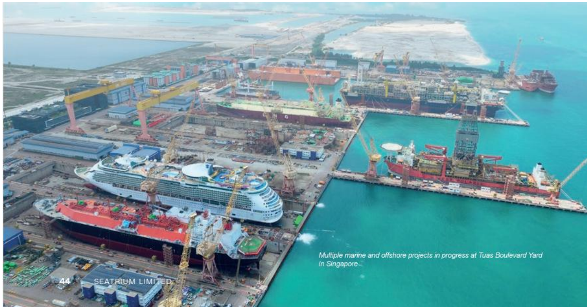
図 25 トゥアス・ブルバード・ヤードの全景
