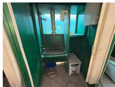
溶接ブースの内部
