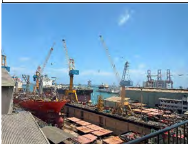
コロンボドックヤード外観
