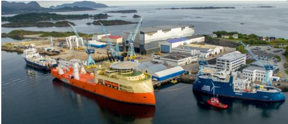
Ulstein Verft 造船所全景 出所 : Ulstein Verft
