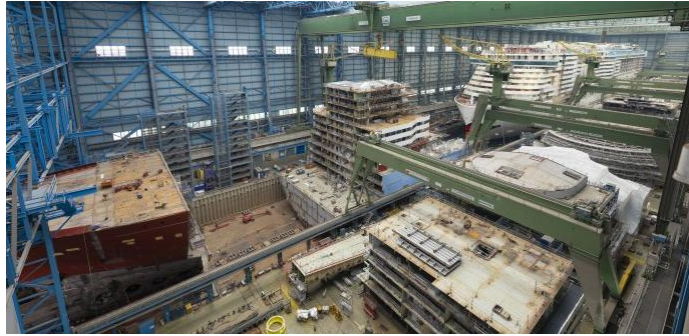
屋内建造ドック 出所：MEYER WERFT
