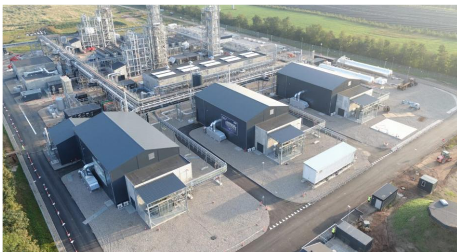
図 21 Kassø e-メタノールプラント
