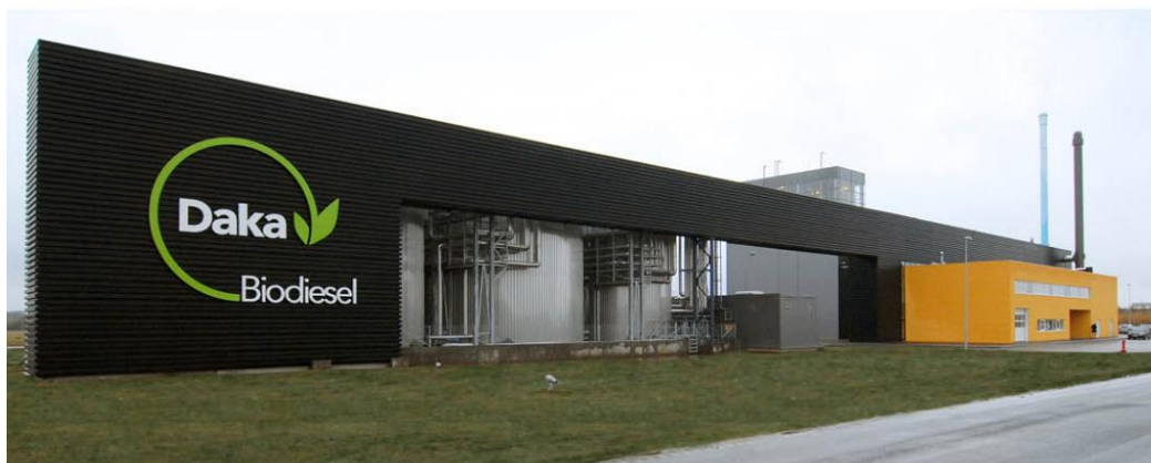
図 14 DAKA バイオディーゼルプラント（デンマークロスニング）
