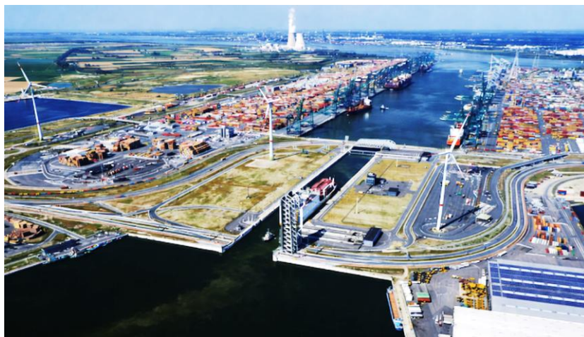
図 26 アントワープ・ブルージュ港における「Power to Hydrogen」プロジェクト
