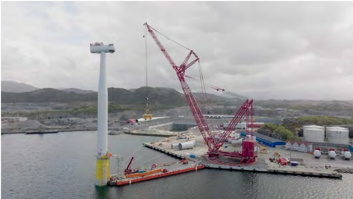
図 41 Hywind Tampen におけるタービンの据付作業の様子 (Equinor, Jan Arne World, Worldcam)
