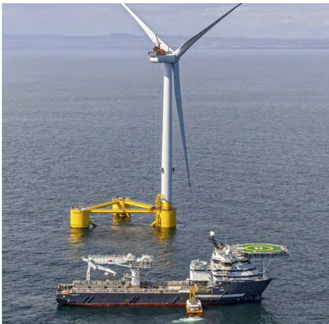
図 70 GenHook による作業の様子 (Offshore Channel.com)
