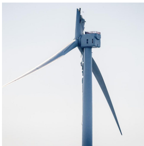
図 13 ヴィンヤード・ウインドの風力発電設備の折れたブレード
