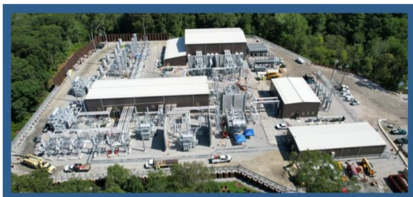
図表 33 レボリューション・ウインド陸上変電所の建設状況（2025年7月時点）
