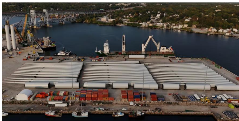
図表 34 コネチカット州、州営棧橋にあるレボリューション・ウインドの建設準備拠点
