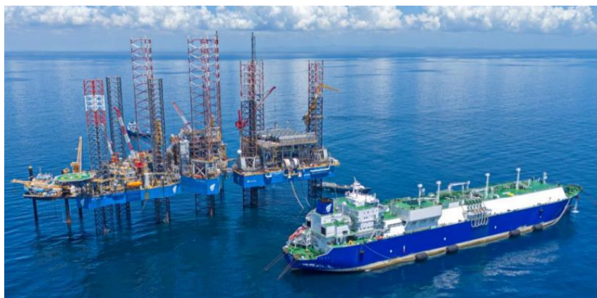
図表 23 2024年にメキシコ湾に設置されたニューフォートレス・エナジーの LNG 輸出プラント
