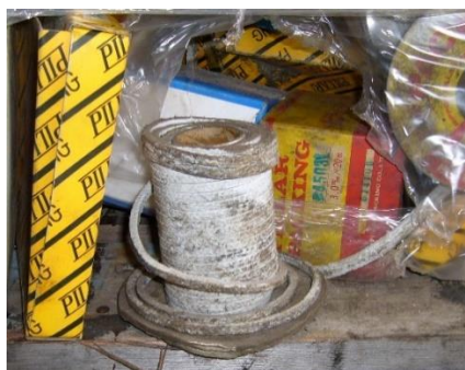
図 2-10 低圧配管用フランジシートパッキン（左）及び 弁グランドパッキン（右）
