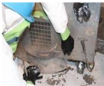
集じん・排気装置の排気口をビニールシート等で封鎖
