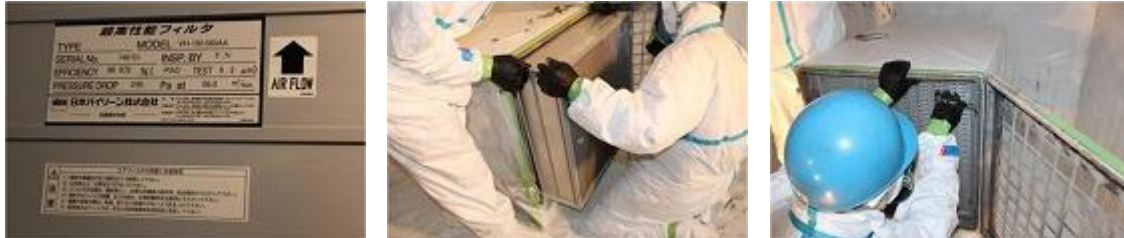
参考図 3.58 フィルタの取り付け
