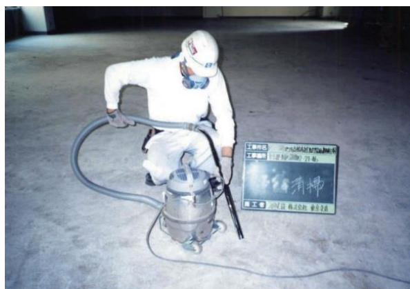
図4.10.11 清掃 高性能真空掃除機使用例
