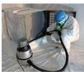
参考図 3.55 HEPAフィルタ等の清掃
