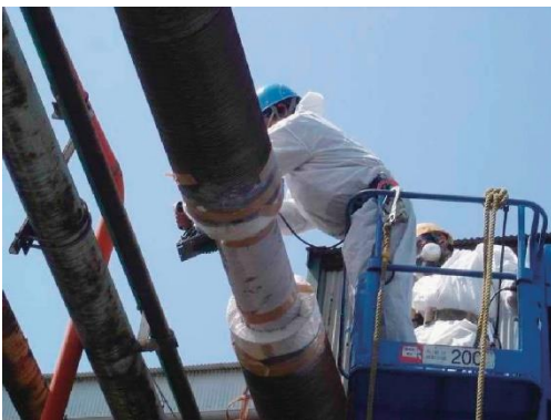
図4.8.5 切断箇所の除去と養生
