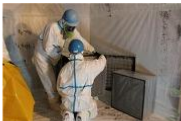
参考図 3.57 HEPAフィルタの交換
