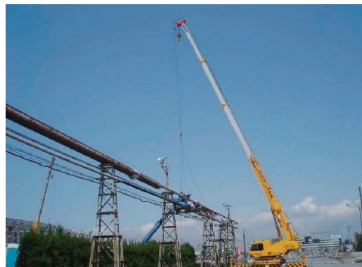
図4.8.6 配管吊り下ろし
