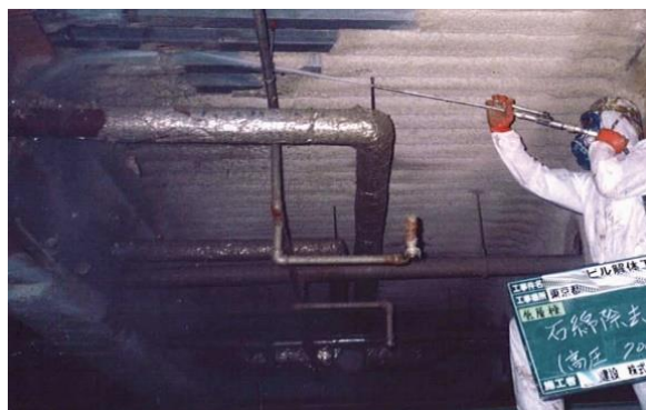
参考図 3.35 ウォータジェット工法の例
