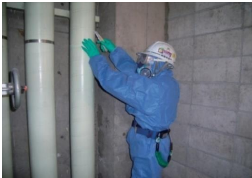
図4.7.2 保温材被覆撤去
