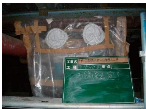
図4.8.10 石綿除去作業中1
