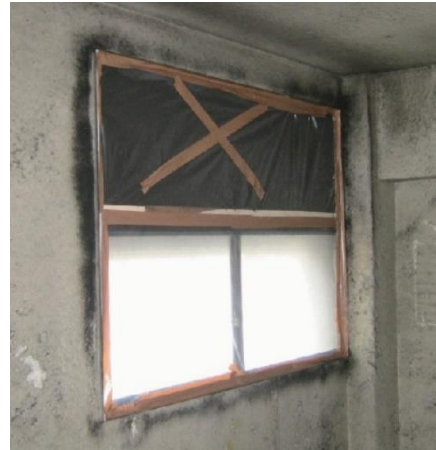
参考図 3.7 窓、換気口の隔離例
