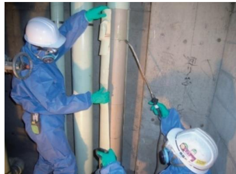
図4.7.3 保温材の取外し
