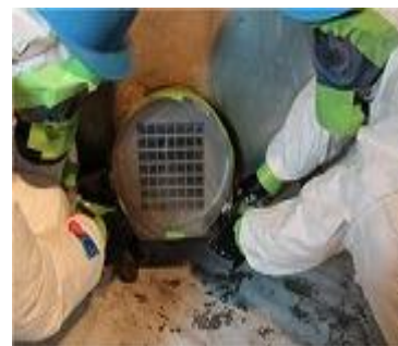
集じん・排気装置の排気口をビニールシート等で封鎖
