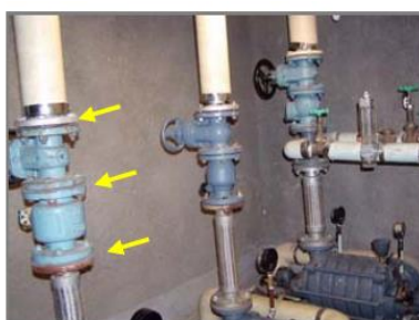
バルブ継ぎ手部などへのパッキング・ガスケット （継ぎ目に挟まっていますので写真では見え ていません）
