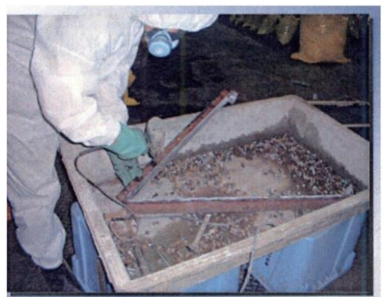
図4.10.7 掻き落とし除去作業の例
