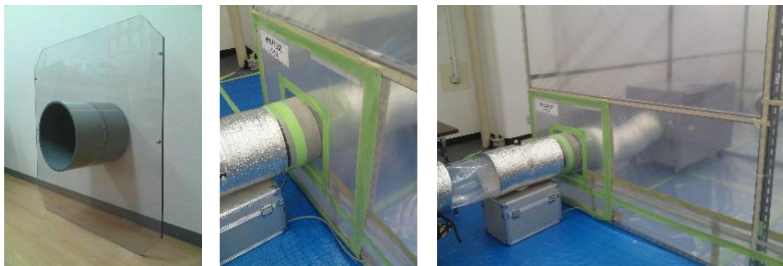
参考図 4.14 排気ダクト貫通パネル例
