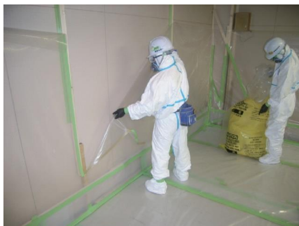
参考図3.63 隔離シートの撤去
