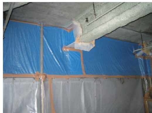
参考図 3.5 壁面の隔離例 (作業場内側)
