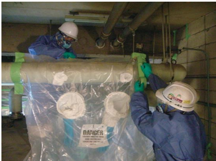
図4.8.2 グローブバッグの例
