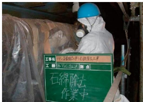
図4.8.10 石綿除去作業中1
