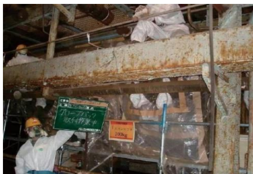
図4.8.9 特殊グローブバッグ取付作業中
