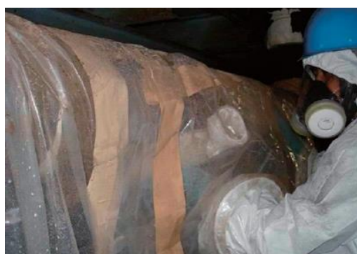
図4.8.9 特殊グローブバッグ取付作業中
