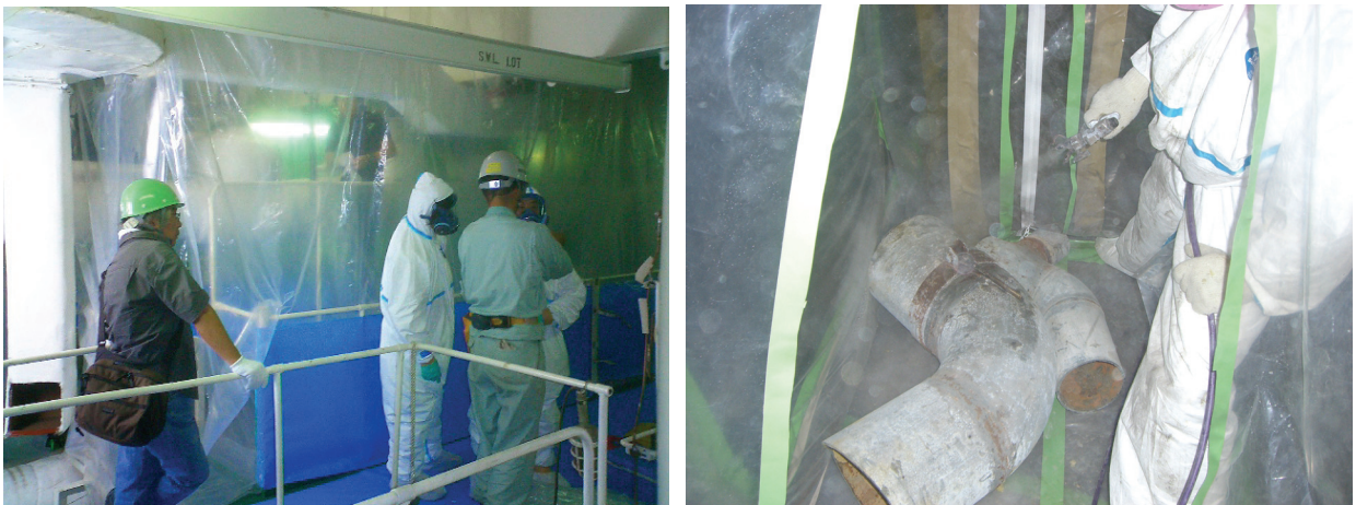
図 5-2-2 プラスチックシート等で養生。ダクトで負圧・除じん装置と接続
