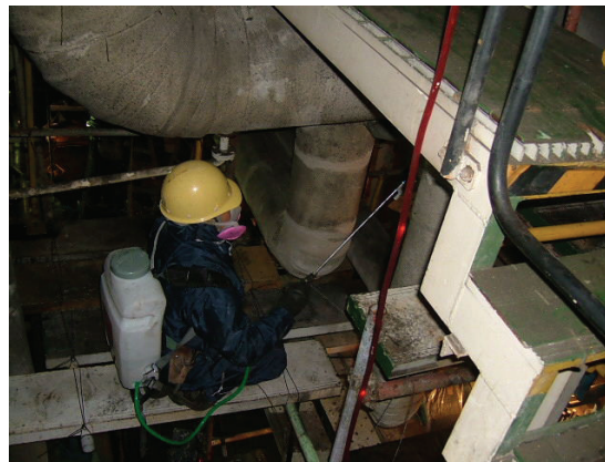
図 5-1-12 噴霧器を使用してのアスベストの湿潤作業中
