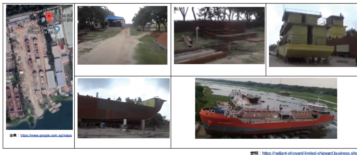
図 5-5 : Radiant Shipyard Limitedのヤード
