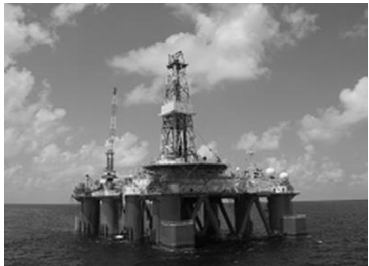
図 10 浮体構造物が没水した Hakuryu-5 [6]
