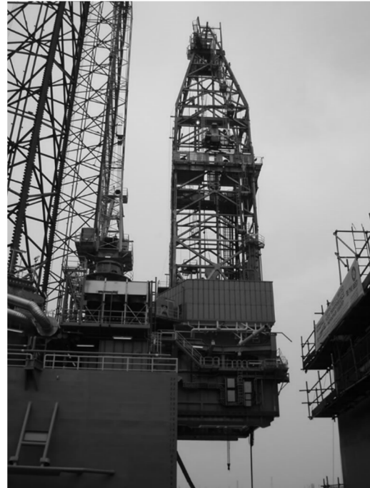
図 46 自己昇降式掘削装置のカンチレバー上に設けられたデリック
