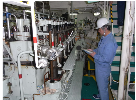
図3 機関室での騒音測定
