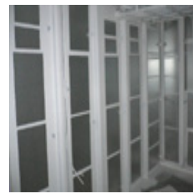
図 2.3.9 鋼壁への施工例 2
