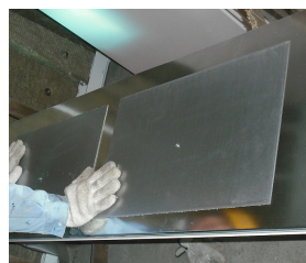
図 2.3.12 制振材をビス止め
