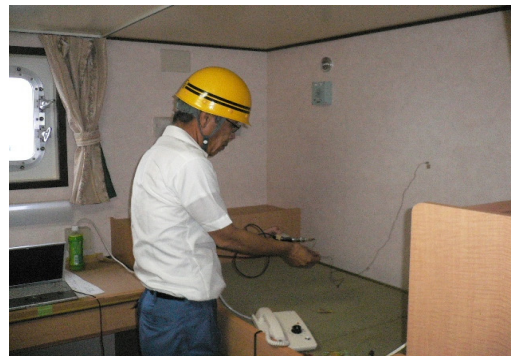
図6 振動加速度センサーの設置
