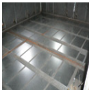
図 2.3.16 制振材貼り付け後の床
