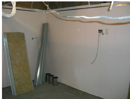
図 2.3.14 居住区周壁のカセットパネル
