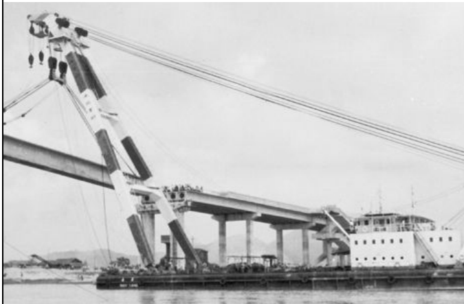
500トンクレーン船
