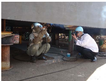
タイプ B による上向き隅肉溶接作業のデモンストレーション
