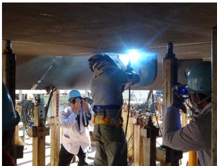
タイプ A による上向き吊りピース溶接作業のデモンストレーション
