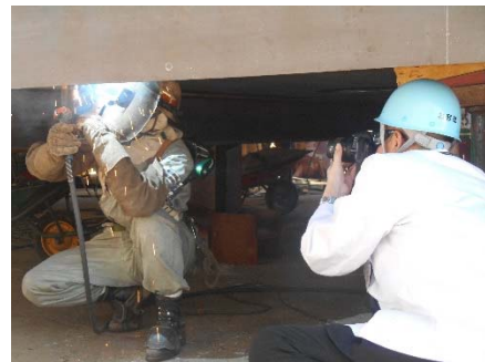
タイプ B による上向き隅肉溶接作業のデモンストレーション
