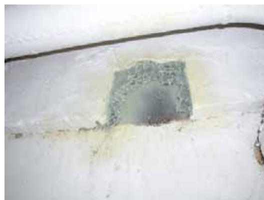
(吹き付け表面が、 plaster (漆喰のようなもの) で押さえられています。右はそれを切り取ったところです)
