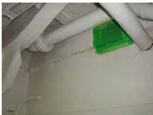
(吹き付け表面が、 plaster (漆喰のようなもの) で押さえられています。右はそれを切り取ったところです)
