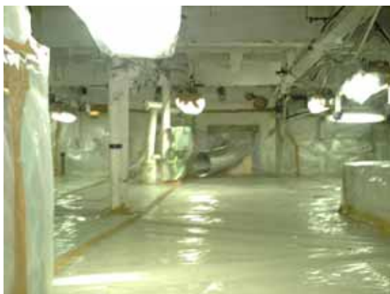
(ポリフィルムシート2枚重ね。ダクトで負圧除じん装置へ)
