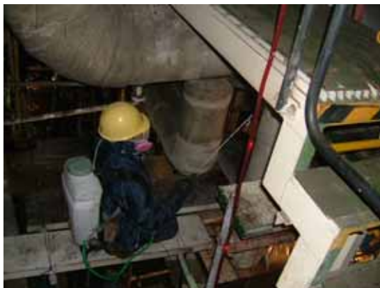
(噴霧器を使用してのアスベストの湿潤作業中)
