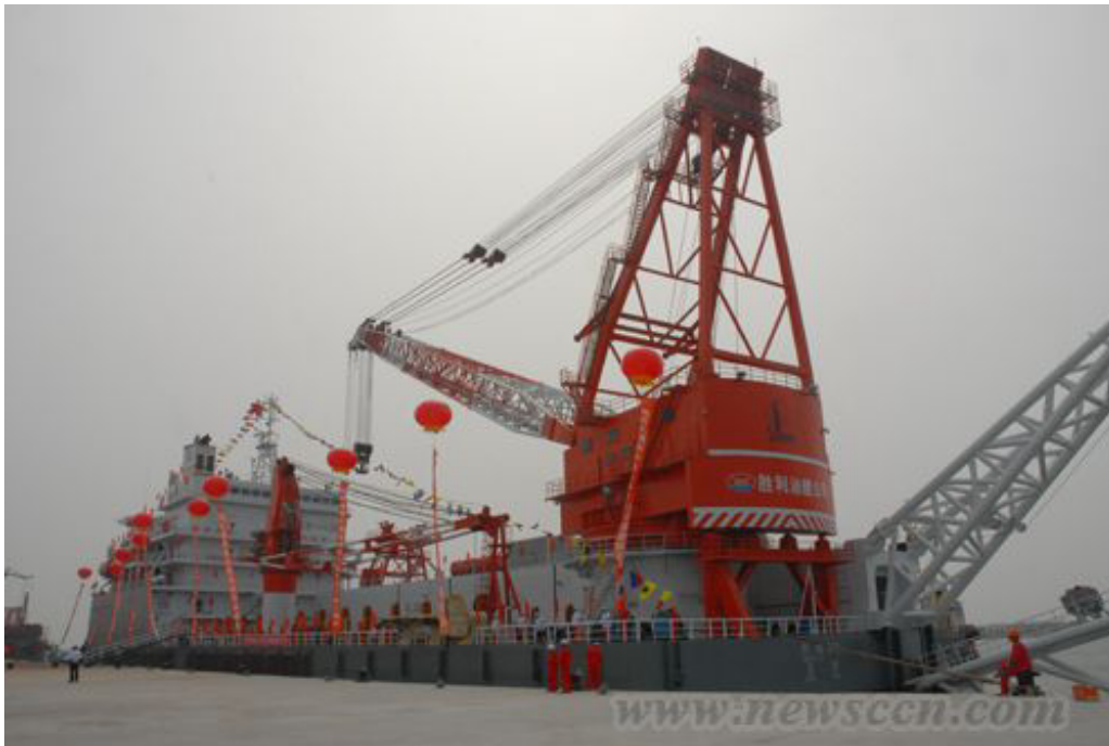
「中国石化」最大のパイプ敷設船
