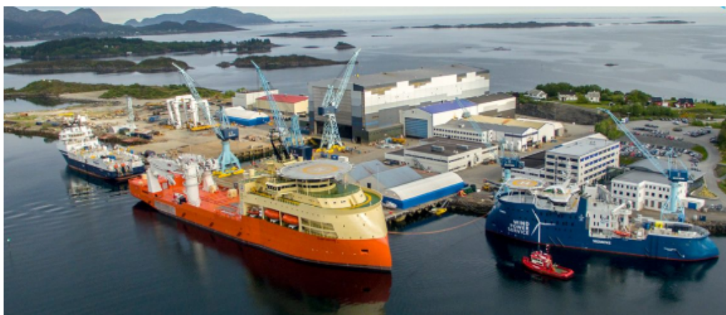
Ulstein Verft 造船所全景（出典：Ulstein Verft）
