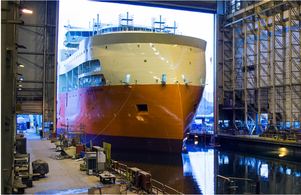
Ulstein Verft 屋内ドック（出典：Ulstein）
