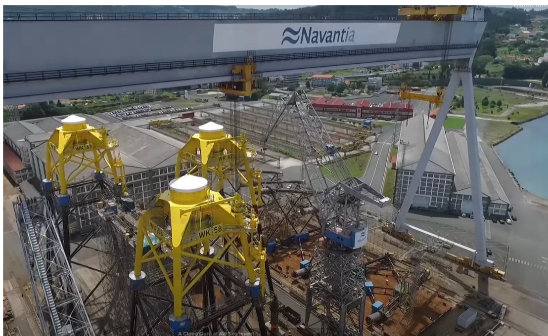
(写真) Navantia で建造中のジャケット構造物
