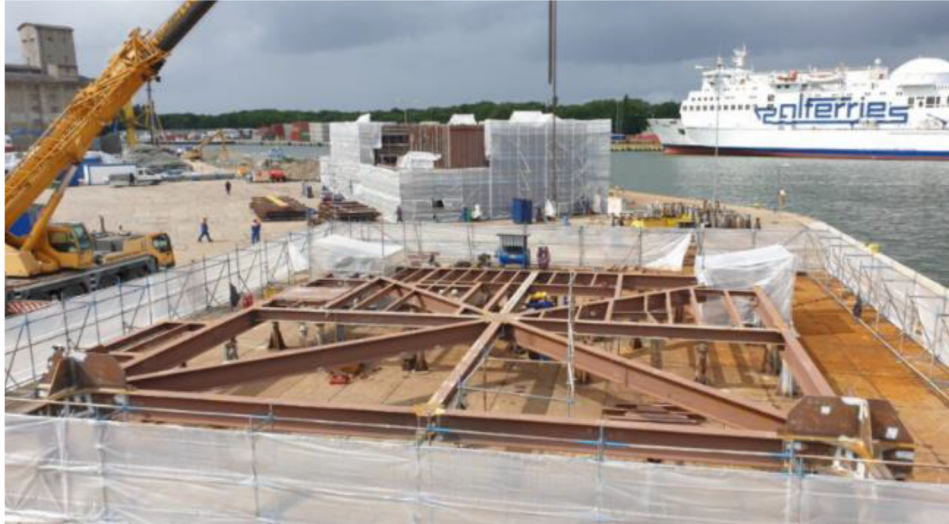
(写真) 旧 Lenin Shipyard で建造中の洋上変電施設のトップサイド
