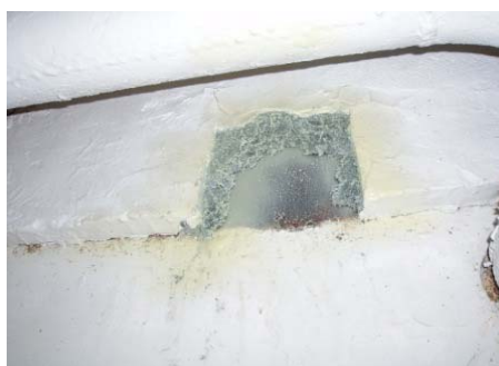
図 2-3 吹き付け表面がプラスター（漆喰のようなもの）で押さえられた写真（左）それを切り取った写真（右）
