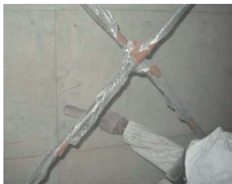
参考図3.44ワイヤブラシを用いた擦り落とし作業
