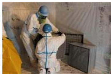
参考図 3.57 HEPA フィルタの交換
