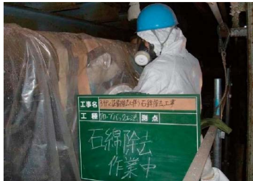
図4.8.10 石綿除去作業中1
