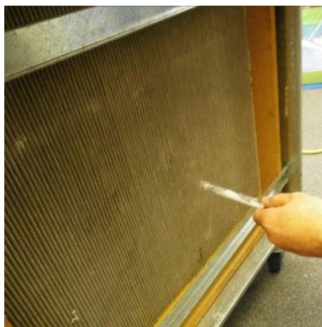
参考図3.24 HEPAフィルター面
