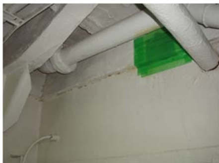
図 2-3 吹き付け表面がプラスター（漆喰のようなもの）で押さえられた写真（左）それを切り取った写真（右）
