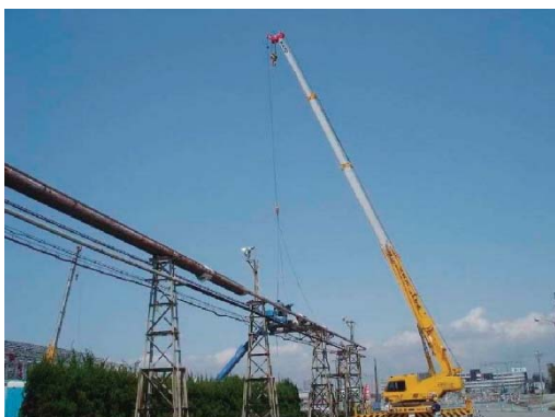
図4.8.6 配管吊り下ろし
