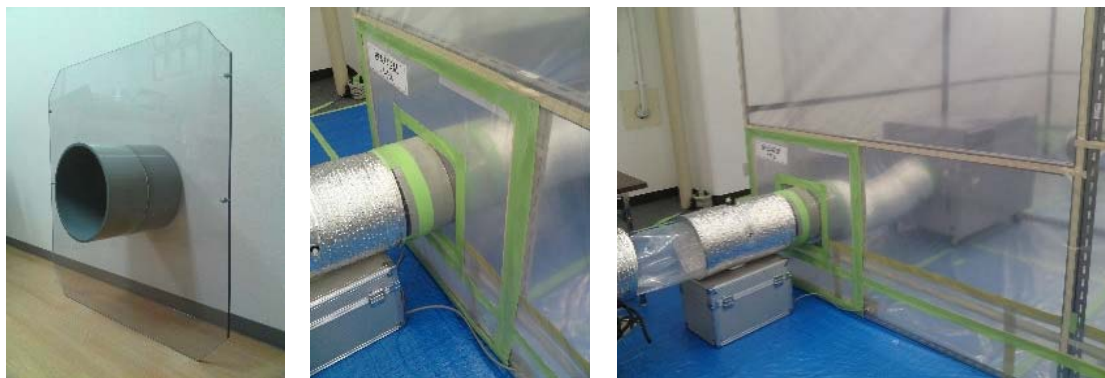
参考図 4.14 排気ダクト貫通パネル例
