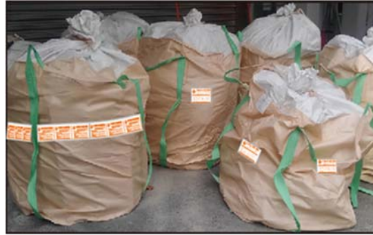
図4.10.12 石綿含有成形板廃棄物の保管例
