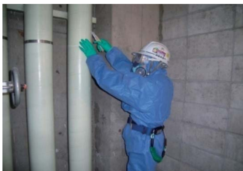
図4.7.2 保温材被覆撤去
