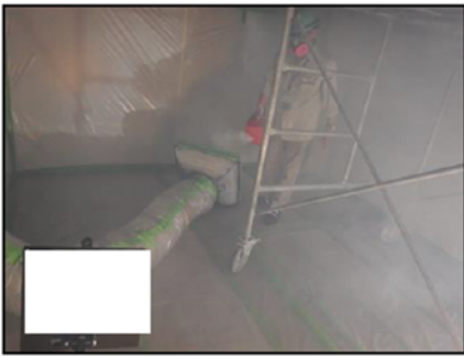
参考図 4.8 スモークマシンを使用した空気の流れの確認（集じん・排気装置設置時）
