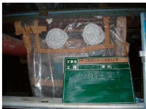
図4.8.10 石綿除去作業中1
