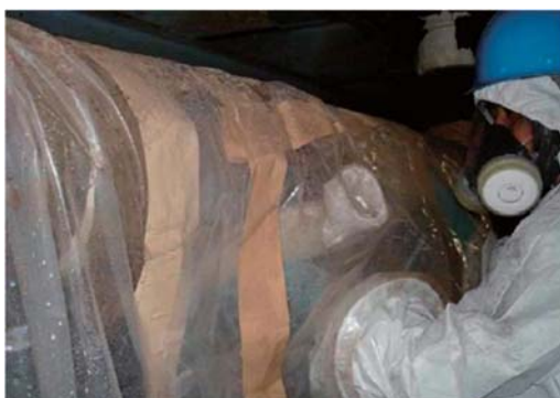
図4.8.11 石綿除去作業中2
