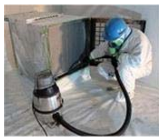
参考図 3.55 HEPA フィルタ等の清掃
