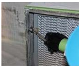
参考図 3.56 HEPA フィルタの留め付けの緩み点検
