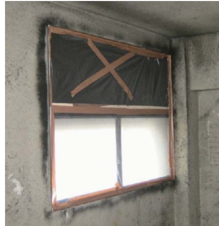
参考図 3.7 窓、換気口の隔離例
