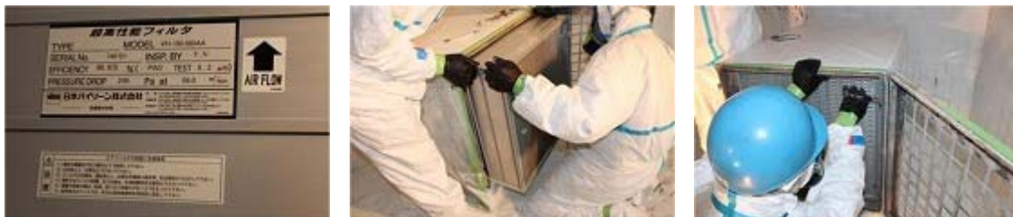
参考図 3.58 フィルタの取り付け
