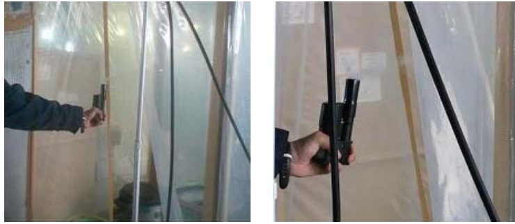
参考図 4.9 セキュリティーゾーンの入口の気流方向の確認
