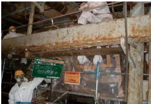
図4.8.9 特殊グローブバッグ取付作業中
