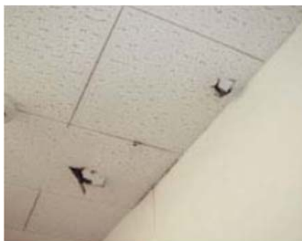
図 2-8 天井吸音材
