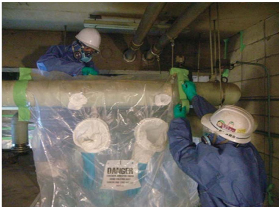
図4.8.2 グローブバッグの例
