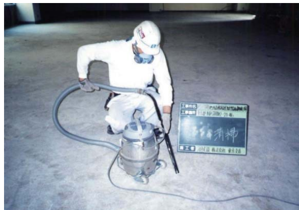
図4.10.11 清掃 高性能真空掃除機使用例
