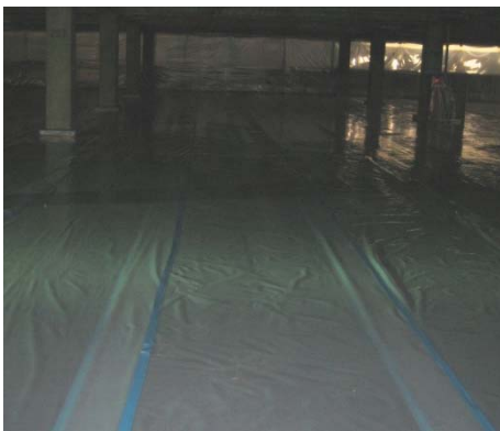
参考図 3.4 床面の隔離例(2重張り)
