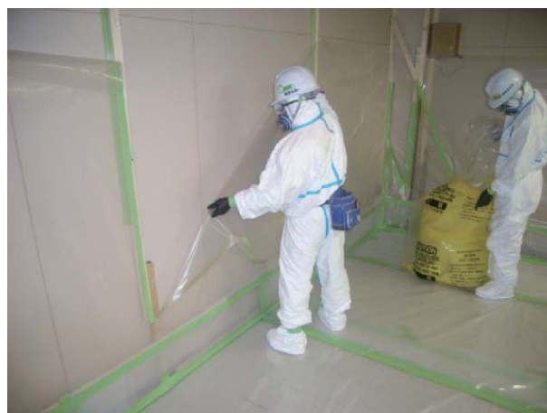
参考図3.63 隔離シートの撤去
