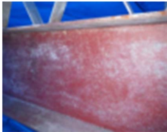
参考図3.42 再付着した石綿の例
