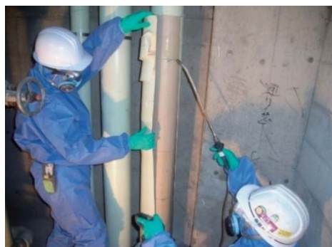
図4.7.3 保温材の取外し
