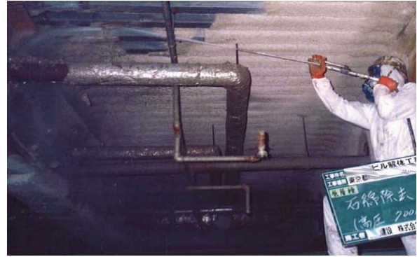
参考図 3.35 ウォータジェット工法の例
