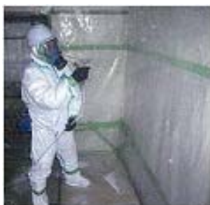
②隔離シートへの散布
