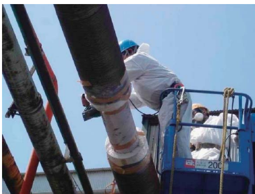
図4.8.5 切断箇所の除去と養生
