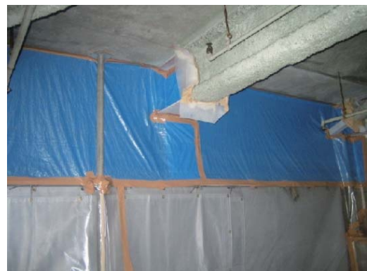
参考図 3.5 壁面の隔離例(作業場内側)
