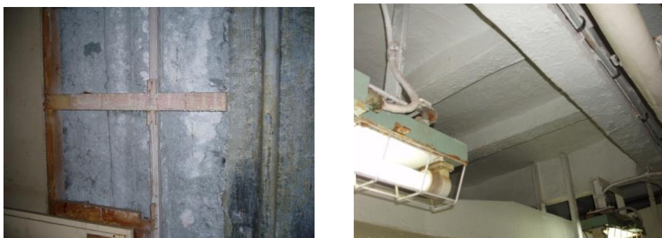
図 3.2 居住区壁裏の石綿含有吹付け材（左）天井に吹付けられた結露防止石綿材（右）
