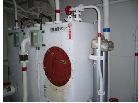
図 3.4 タンクの保温板。保温板の表面にアスベストクロスを貼り付けて金網で補強（左）、右はブリキ板で補強
