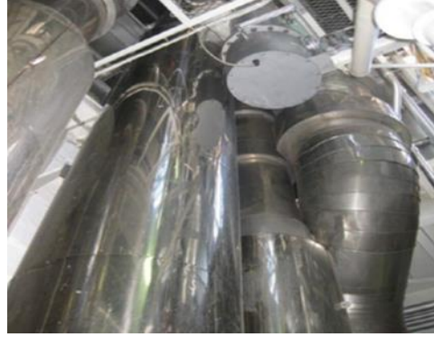
図 3.18-2 煙突内の排気管群
