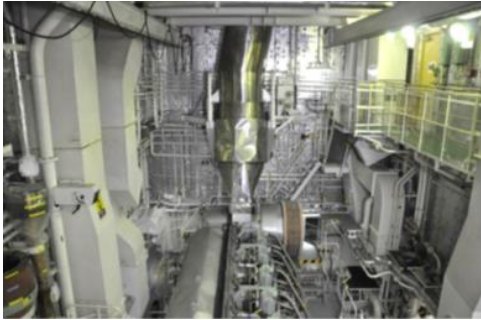
図 3.17-1 2nd デッキ機関室外観
