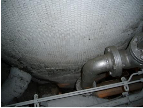
図 3.4 タンクの保温板。保温板の表面にアスベストクロスを貼り付けて金網で補強（左）、右はブリキ板で補強
