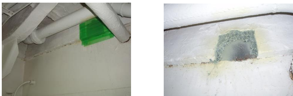
図 3.3 吹き付け表面がプラスター（漆喰のようなもの）で押さえられた写真（左） それを切り取った写真（右）
