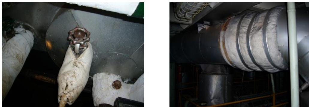
図 3.7 蒸気弁に使用のアスベスト布団（左）及び 排気管エキスパンション部アスベスト布団（右）
