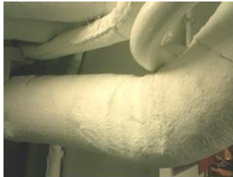
図 3.5 アスベストクロス（左）及び アスベストクロスを巻き付けた蒸気配管（右）
