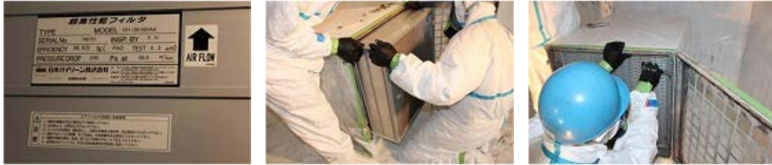
参考図 3.58 フィルタの取り付け
