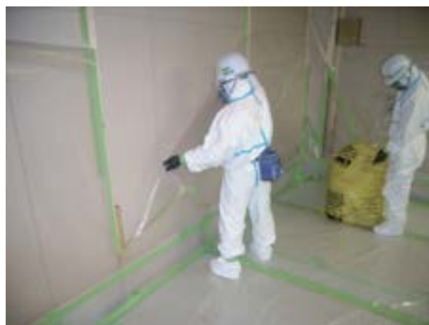
参考図3.63 隔離シートの撤去
