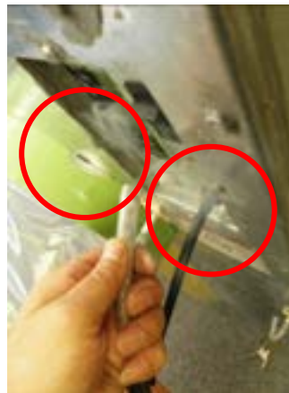
参考図3.30 スイッチ等の取り付け部電源コード取り付け部
