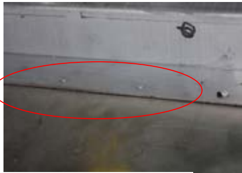
HEPA フィルタ取り付け面
