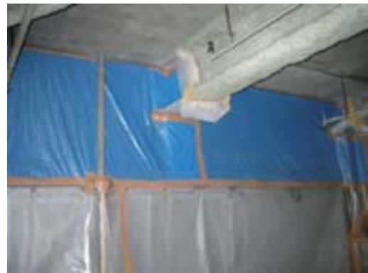
参考図 3.5 壁面の隔離例(作業場内側)
