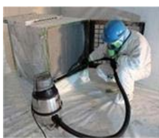
参考図 3.55 HEPA フィルタ等の清掃
