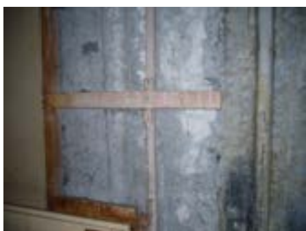
図 2-2 居住区壁裏の石綿含有吹付け材（左）天井に吹付けられた結露防止石綿材（右）
