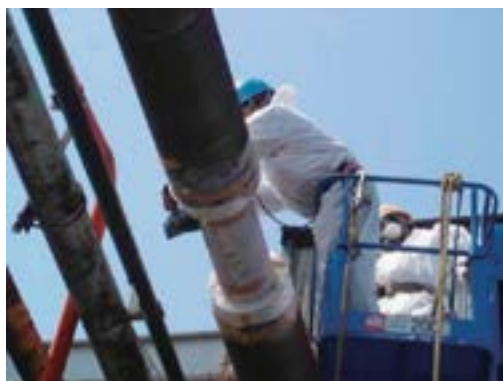
図4.8.5 切断箇所の除去と養生
