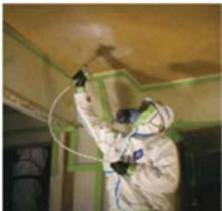
参考図3.41 粉じん飛散抑制剤の散布による湿潤化
