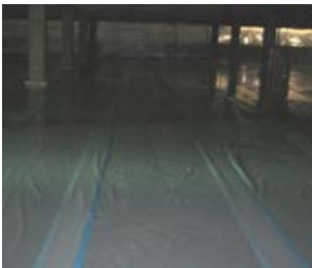
参考図 3.4 床面の隔離例(2重張り)
