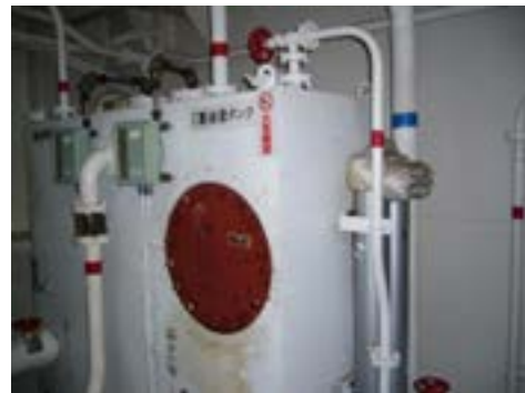
図 2-4 タンクの保温板。保温板の表面にアスベストクロスを貼り付けて金網で補強（左）、右はブリキ板で補強
