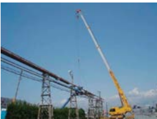
図4.8.6 配管吊り下ろし
