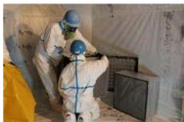
参考図 3.57 HEPA フィルタの交換
