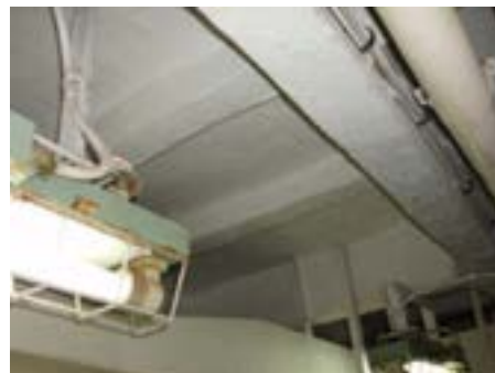
図 2-2 居住区壁裏の石綿含有吹付け材（左）天井に吹付けられた結露防止石綿材（右）
